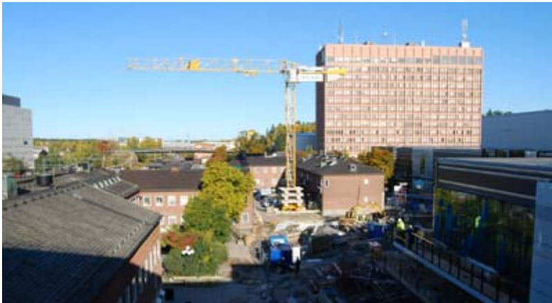
Pålnings- och markarbetet är avslutat och Peab bygger Turebergskyrkan
